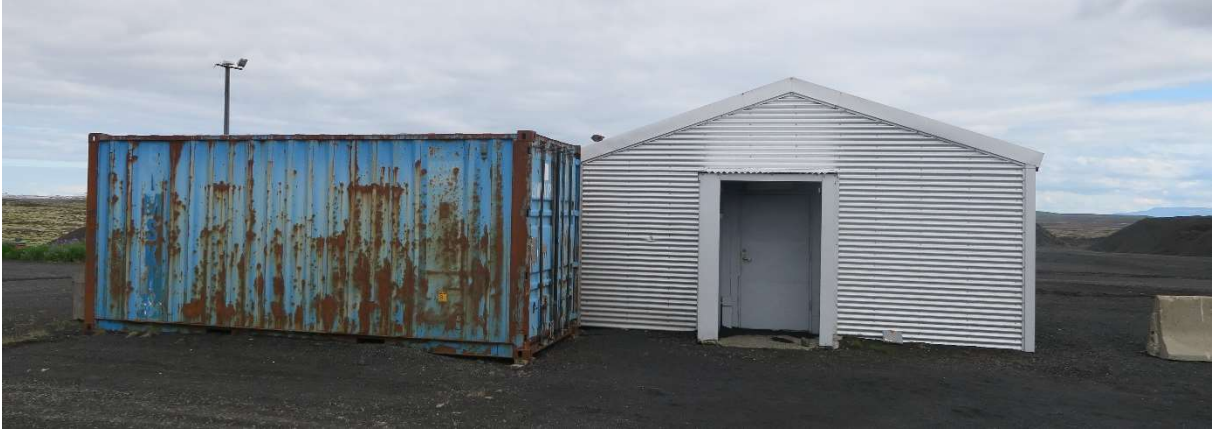
MYND 3.4 Geymslubygging Íslenskra aðalverktaka. Mynd tekin af EFLU verkfræðistofu í júlí 2018.
