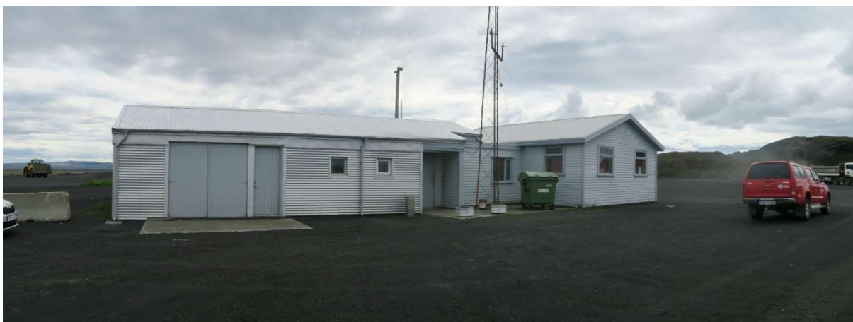
MYND 3.3 Starfsmannaaðstaða Íslenskra aðalverktaka við Súlur og Stapafell. Mynd tekin af EFLU verkfræðistofu í júlí 2018.
